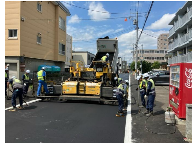
● 舗装工事（1丁目南）
