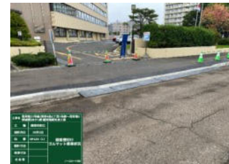
段差解消マット設置
