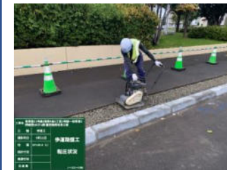
縁石補修箇所の歩道の舗装
