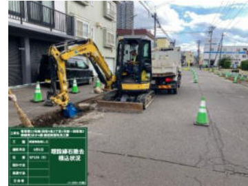
破損した縁石を撤去
