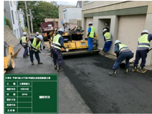
車道舗装工事（1層目）
