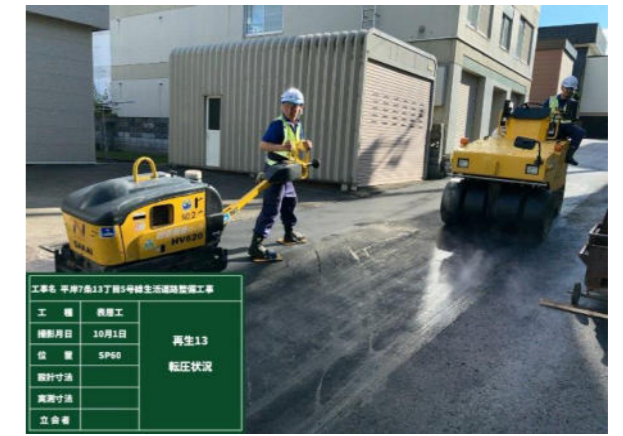
車道舗装工事（2層目）
