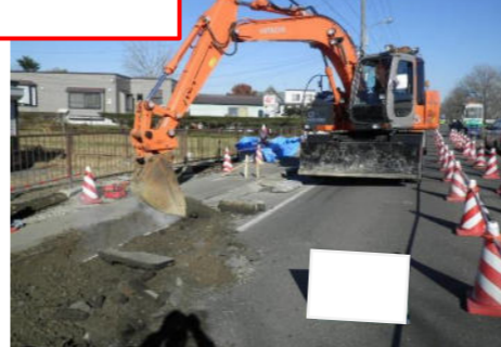
舗装版撤去工事
