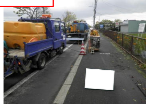
舗装切断工事
