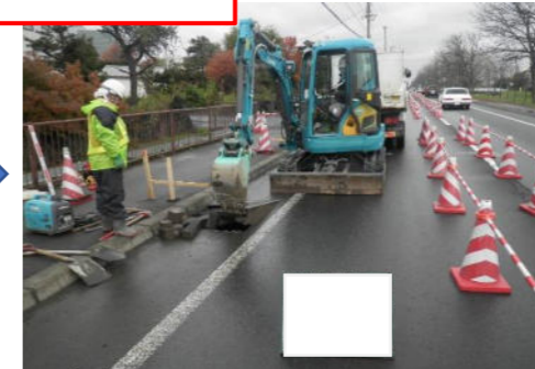
縁石撤去工事
