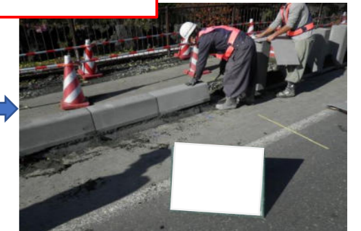
縁石設置工事
