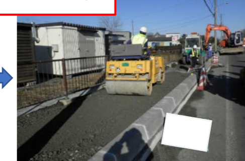
歩道路盤工事
