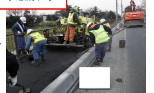
歩道舗装工事
